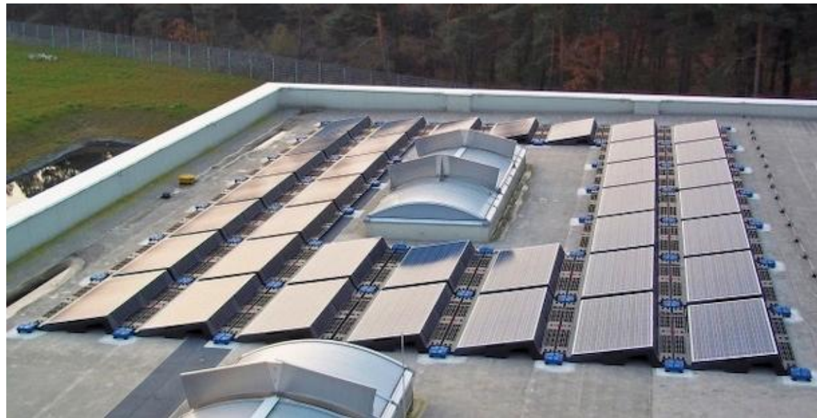
PV-Anlage Flachdach
