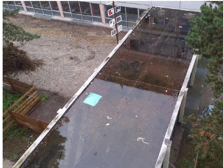
Stehendes Wasser auf dem Null-Grad-Flachdach aufgrund mangelhafter Entwässerung
