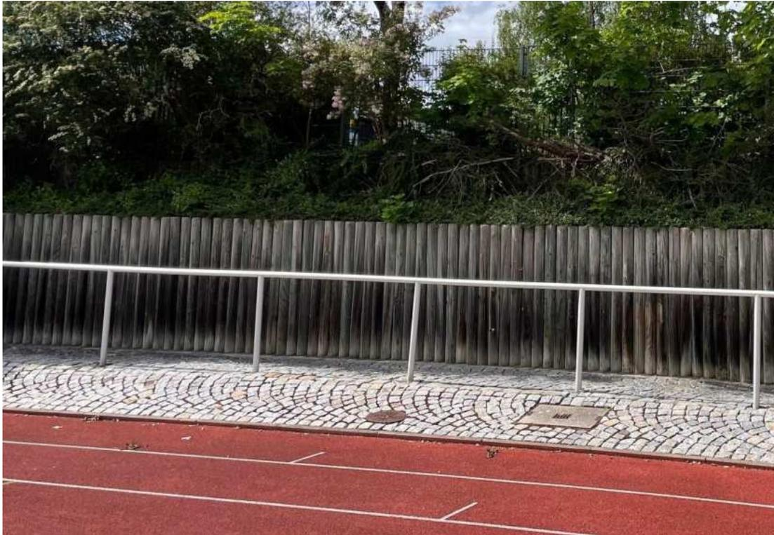
Der Zustand des Holzes ist als mangelhaft einzustufen, da viele der Holzpalisaden morsch sind. Der Kontakt zum feuchten Erdreich sowie die direkte Bewitterung sorgen im Laufe der Jahre für den Zerfall des Holzes.
